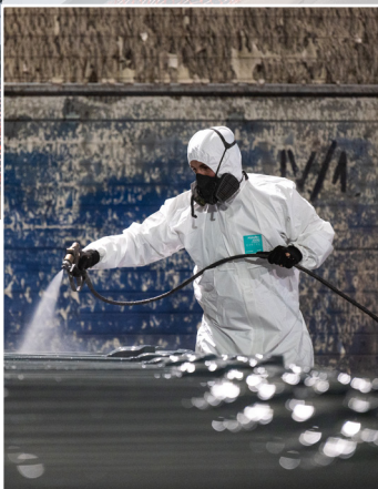
Lánchíd acélszerkezetek üzemi korrózióvédelme csarnokban
