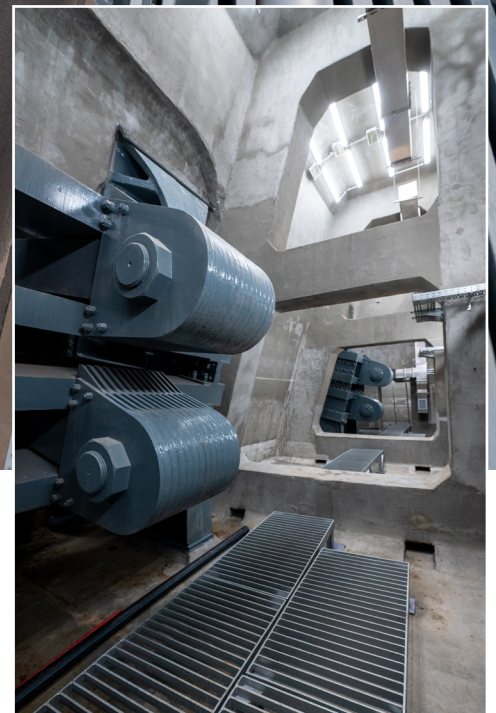
Lánchíd belső szerkezetének korrózióvédelme
