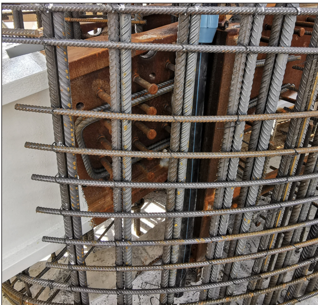
4. ábra: Pilon vasalása a nyeregtartó környezetében (munkaközi állapot)
